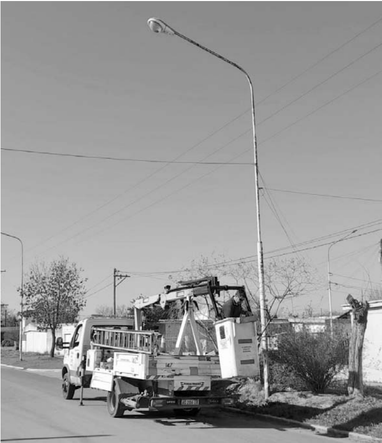
Seguirán en marcha los trabajos para instalar más luces LED en el alumbrado público. (LA OPINION)
