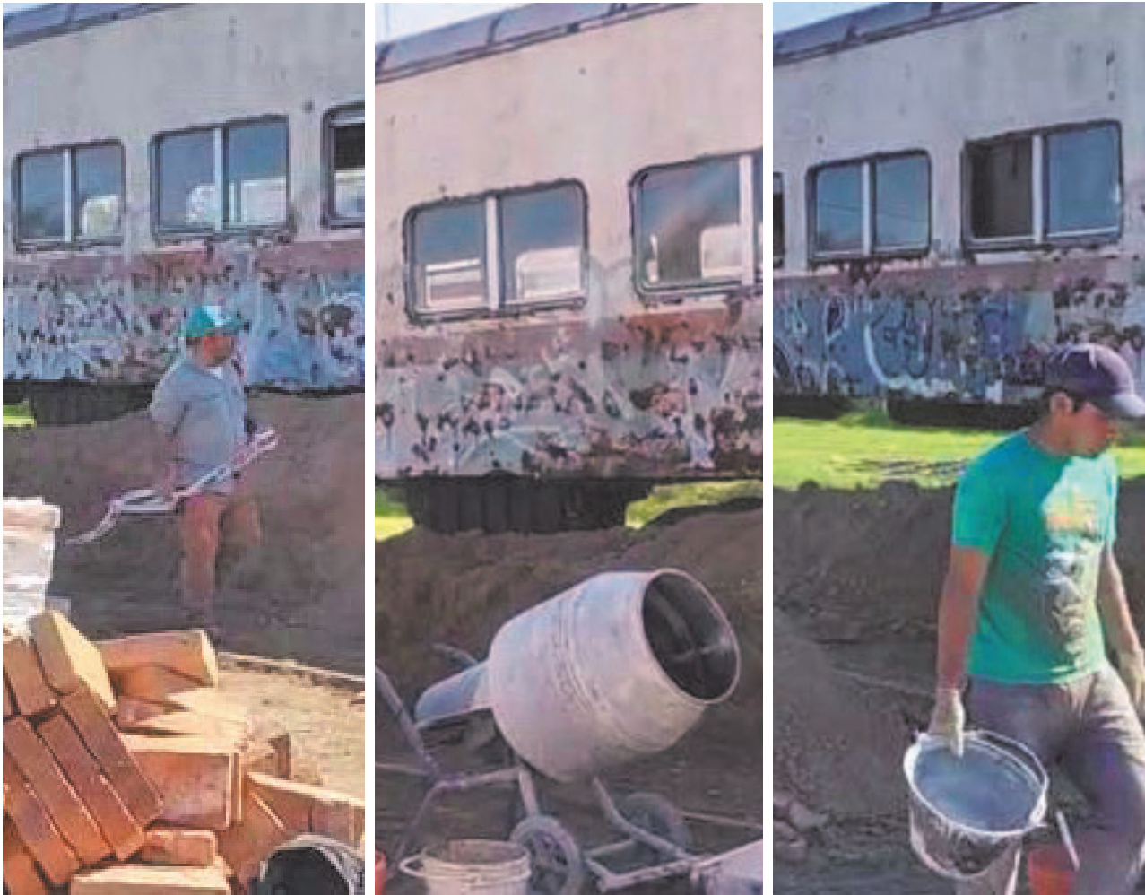
Trabajos en marcha: Para agosto se prevé que estarán terminadas las obras en el Parque España.
