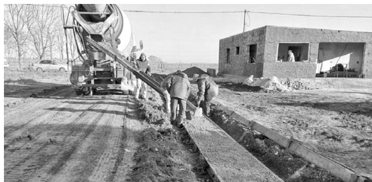
Son permanentes los trabajos que se vienen desarrollando en distintas localidades. (LA OPINION)
