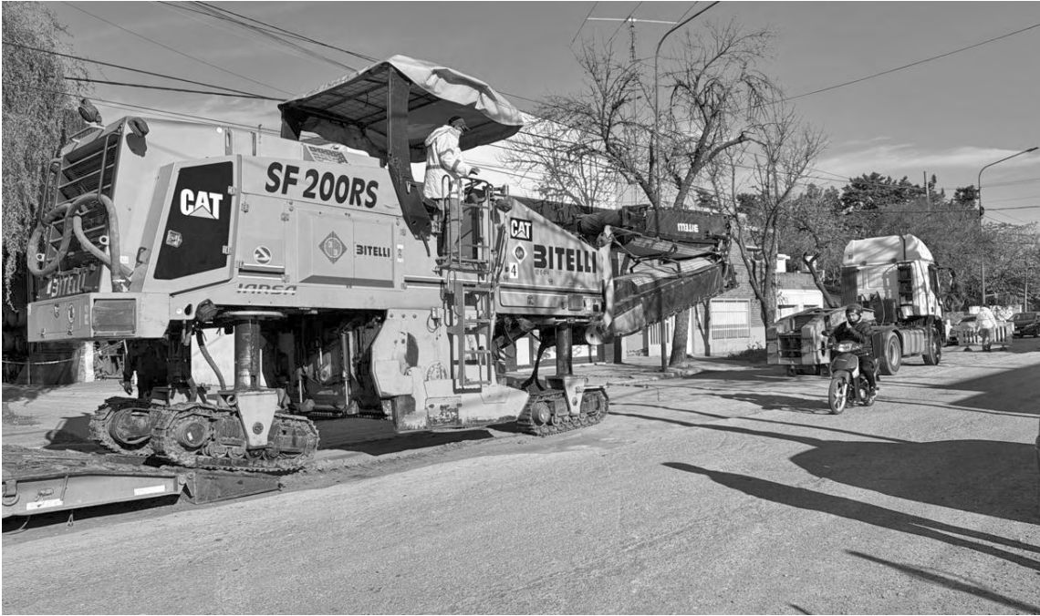
El proyecto contempla la repavimentación completa del tramo que va desde la ruta nacional N° 188 hasta avenida Rocha. (LA OPINION)
