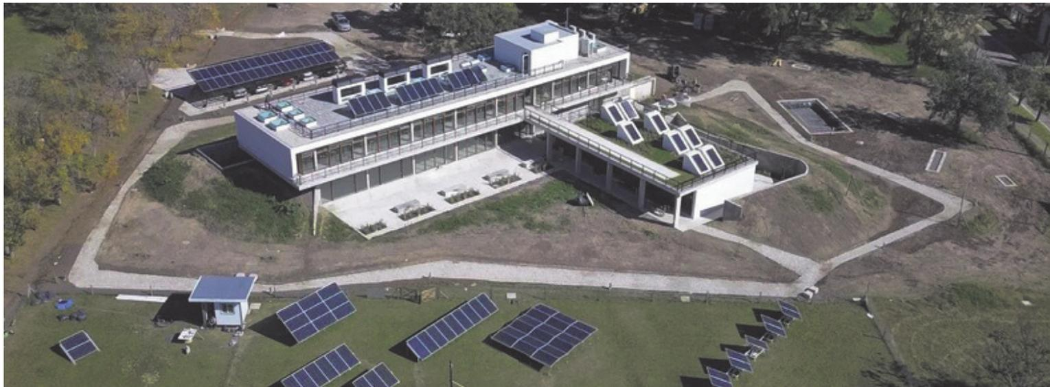
La estructura está construida con ladrillos fabricados a partir de tereftalato de polietileno reciclado, más conocido como PET.
