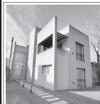
CASA EN CLUB SIRIO 4 DORMITORIOS. Y DEPENDENCIAS MUY BUENA ORIENTACIÓN
