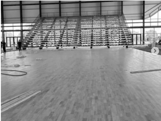
La colocación de nuevo piso de madera forma parte de las etapas finales para el Micro Estadio Municipal de Pergamino. (LA OPINION)
