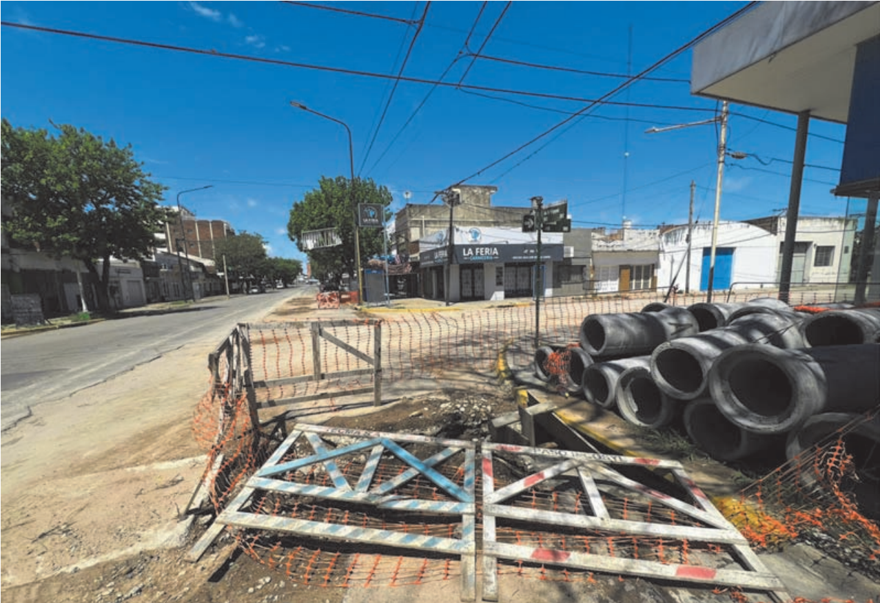
Las empresas se comprometieron a dejar transitable la avenida Yrigoyen pero abandonan los trabajos subterráneos. (LA OPINION)
