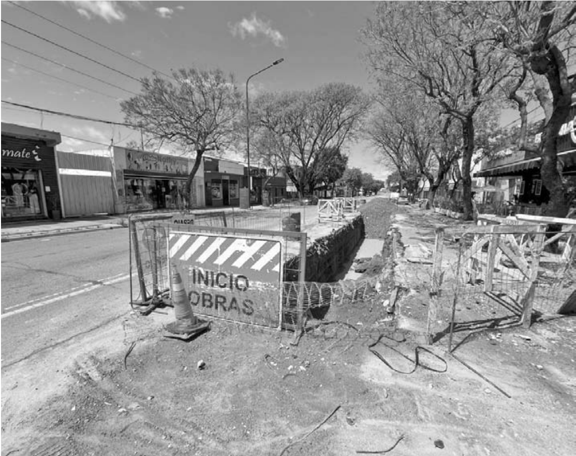
Antes de detener las tareas, los equipos se comprometieron a tapar y reparar los sectores intervenidos del pavimento. (LA OPINION)
