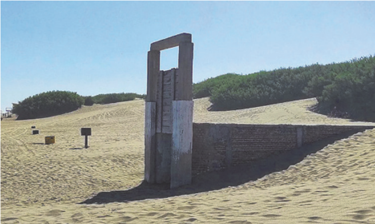
El túnel submedanal de Reta fue construido en 1998. (NA – TRES ARROYOS TURISMO)
