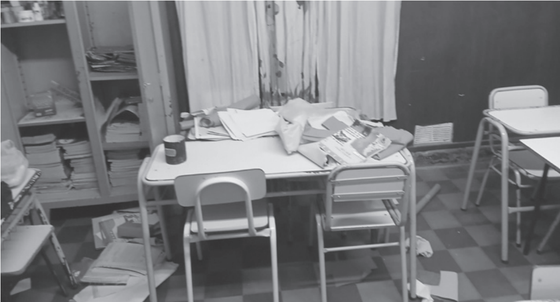
La Escuela Primaria 16, en Florida y Rivadavia, sufrió daños en rejas, puertas y cámaras tras el robo en la madrugada. (LA OPINION)
