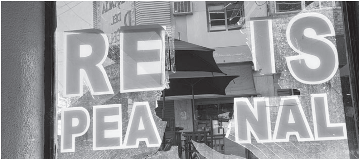
La vidriera dañada de la remisería en la peatonal de Pergamino, tras el hecho de vandalismo ocurrido en la madrugada. (LA OPINION)
