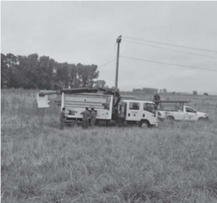
Los operarios de varias cuadrillas de la Cooperativa Eléctrica volvieron a reparar la línea robada. (LA OPINION)
