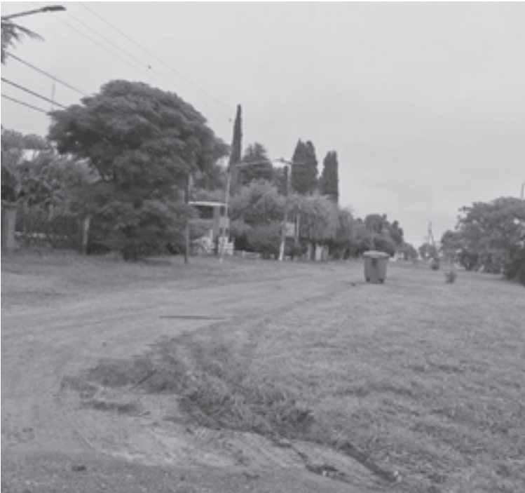
El barrio Aeroclub se vio afectado por el robo de cables en el servicio eléctrico domiciliario. (LA OPINION)
