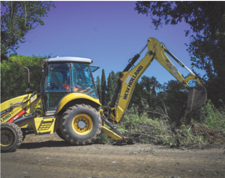
Se realizan tareas de limpieza de canales y desagües pluviales. (PERGAMINO AL DIA)
