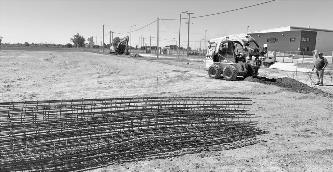
La obra, ejecutada por la empresa Scófano y Cia., contempla una superficie de más de 2.100 metros cuadrados. (LA OPINION)
