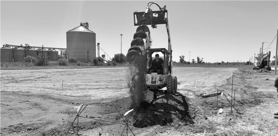
Durante la semana comenzaron las excavaciones para colocar las columnas que sostendrán la estructura. (LA OPINION)
