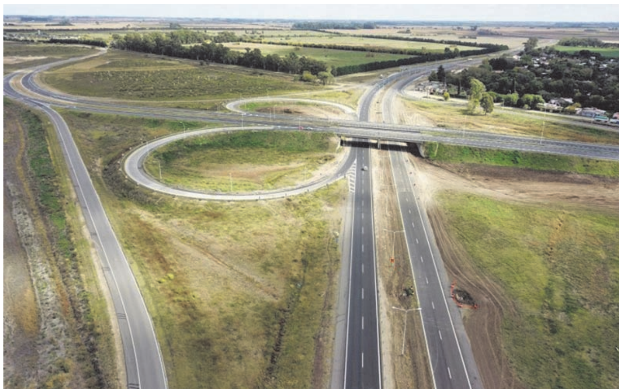
En estos últimos meses, es notorio el estado de deterioro que presentan distintos tramos de esta carretera.
