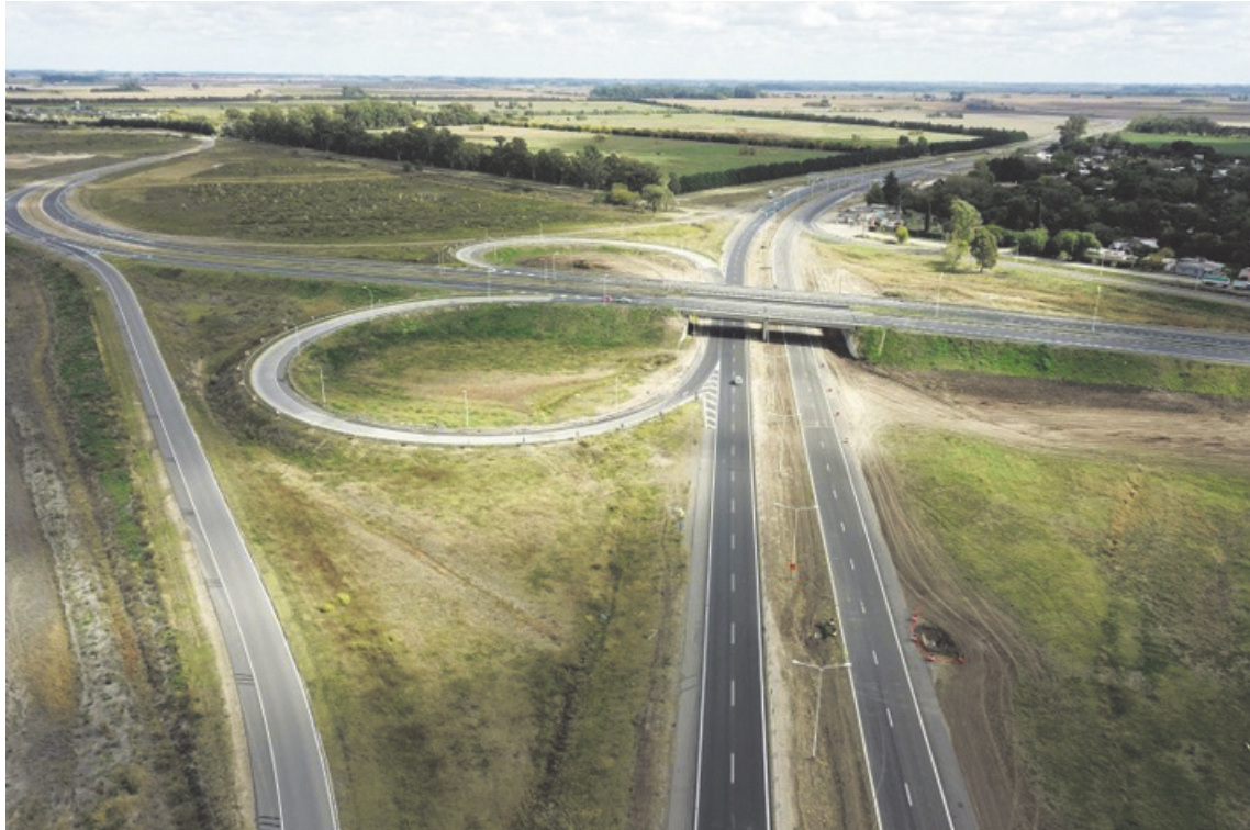
Hay una falta de mantenimiento evidente en la Autopista Pilar - Pergamino y afecta a la seguridad vial de los usuarios. (LA OPINION)
