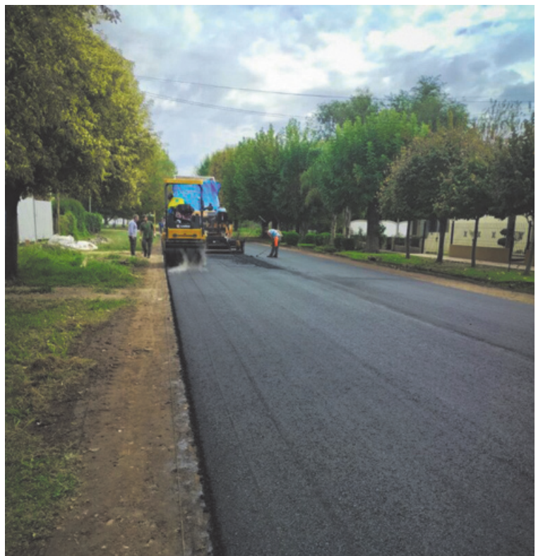
Los vecinos destacan estas obras que se concretaron en el pueblo.
