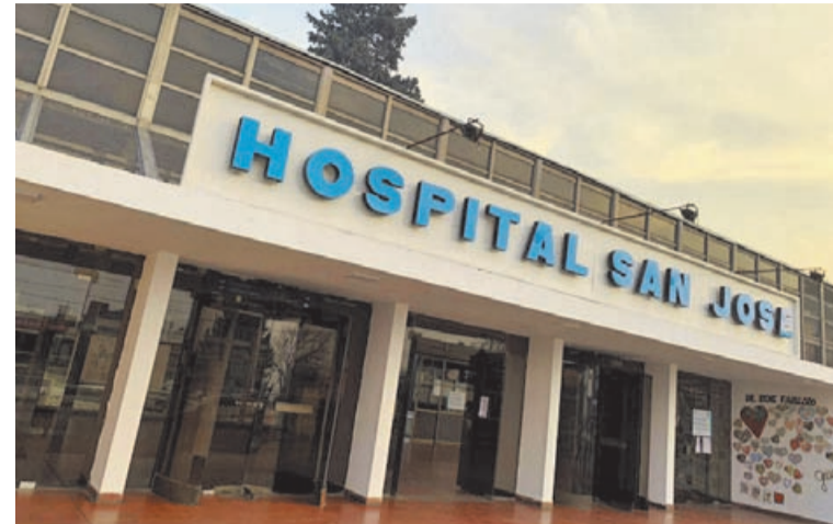
Existe consenso sobre la gravedad de la situación, pero todavía no hay respuestas concretas. (HOSPITAL SAN JOSÉ)
