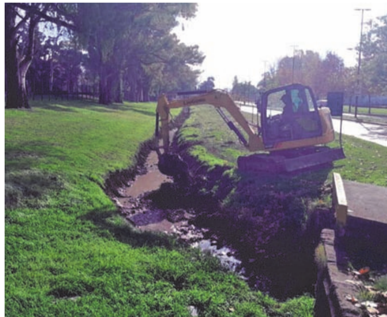
Los trabajos son permanentes en diferentes sectores de la ciudad y resultan claves para evitar anegamientos en días de lluvias. (LA OPINION)
